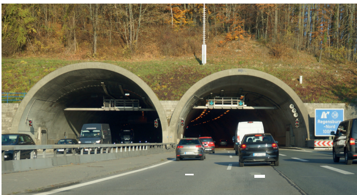
Pfaffensteiner Tunnel: die Sanierung steht an
